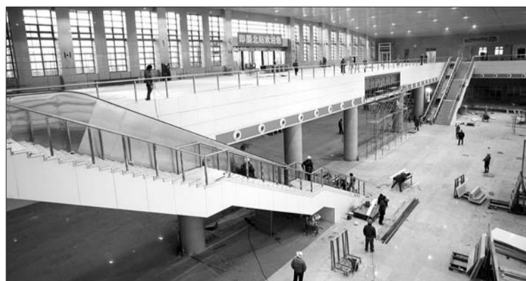
即墨北站内部很宽阔,大厅内部最高垂直高度为16米。
