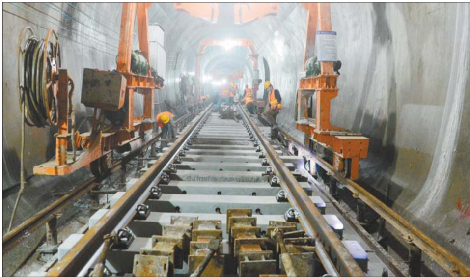
青岛地铁3号线铺轨现场。(青岛地铁集团供图)
