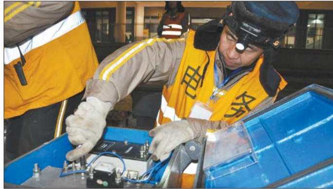
王继强在对轨道电路设备进行维护。
