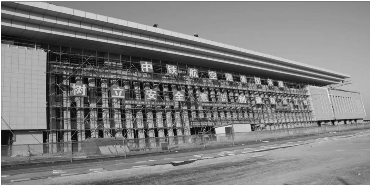
滨州西站客运枢纽中心主体工程已全部封顶。
