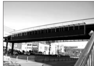
◀ 金宇路一处过街天桥建设已收尾。本报记者 李岩松 摄
