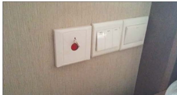
一小区内安装的紧急呼叫系统求助按钮。本报记者 杨思华 摄
