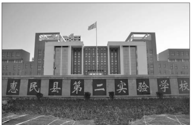
新建成的惠民县第二实验学校。
