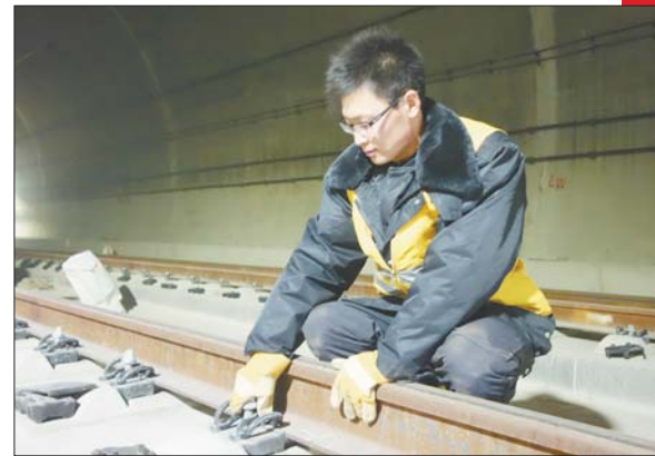
对钢轨扣件进行检查更换。
