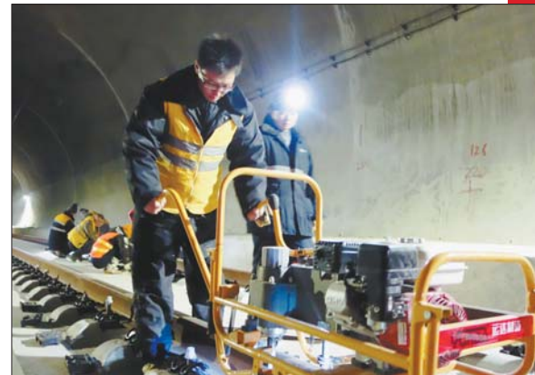
操作机械板手对线路扣件进行紧固。
