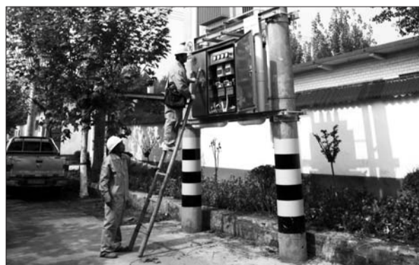
工作人员升级改造香城镇郭桃村的变压器。
