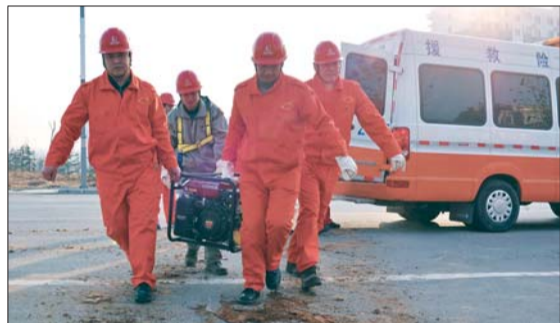
抢修人员携带设备赶到现场。
