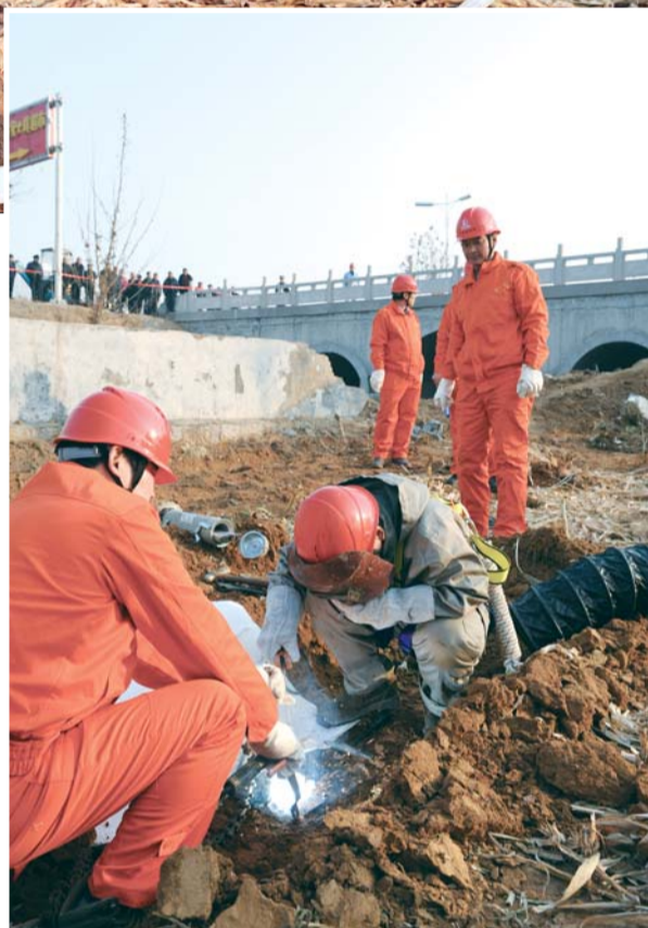
▼对原油“泄漏点”进行排气通风。
