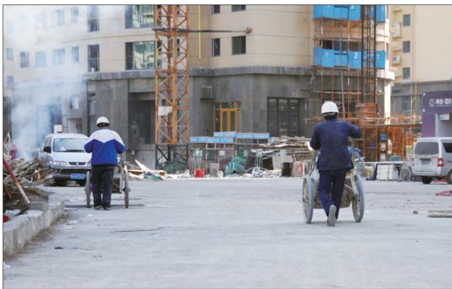
临近年底,淄博部分工地已经陆续停工。 本报记者 王鸿哲 摄
