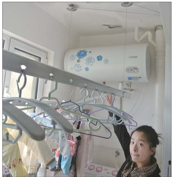
李女士指着阳台顶部说,被修复的墙皮再次开裂,颜色也与原有墙皮不一致。 本报记者 王红星 摄
