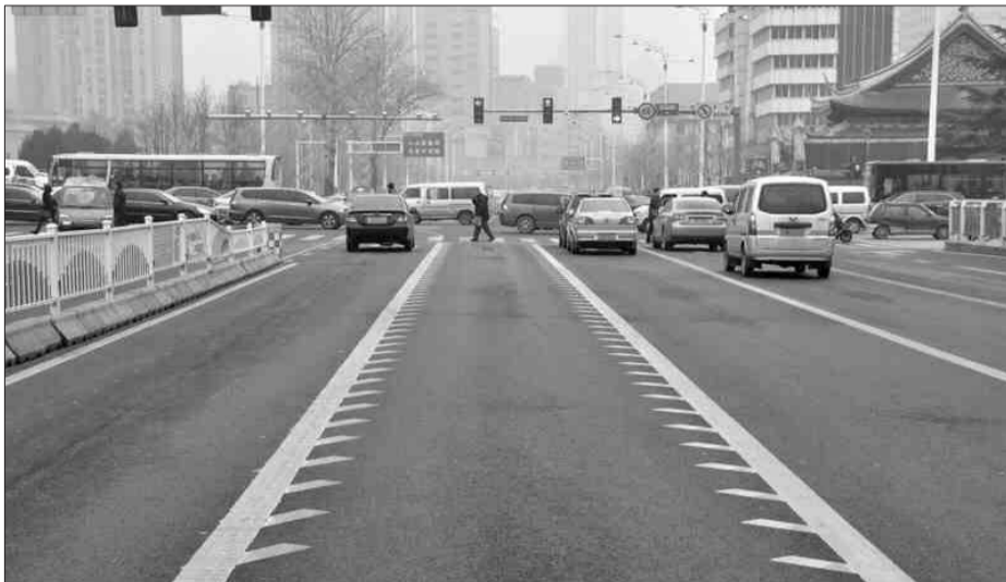
南大街与胜利路东进口第二排车道被设为可变车道,锯齿状的车道很好辨认。 通讯员 全福 摄
