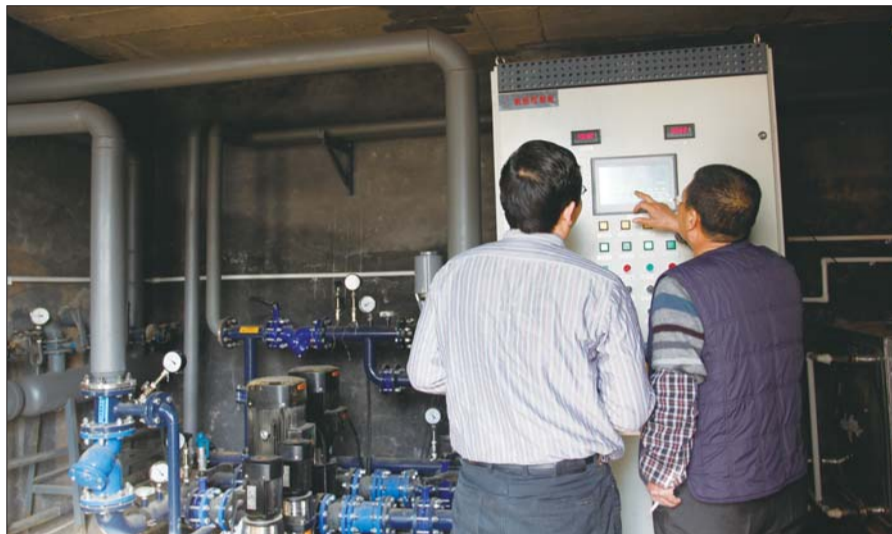
张店城市田园小区换热站正在进行设备调试。 本报记者 唐菁 摄
