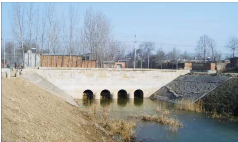
周家店闸越河桥。
