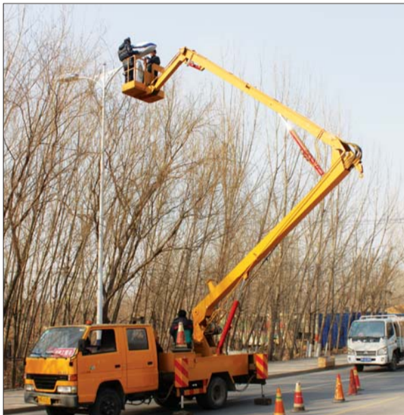
换灯 为保障居民节日期间安全出行,近日,新华街道办事处投资10余万元,重新检修了华润北路的路灯线路,将原来的50盏高压钠灯全部拆除,统一替换为照射范围广、亮度高的LED路灯。 本报记者 贺莹莹 通讯员 李宜乐 摄影报道
