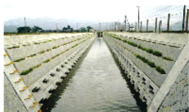
使用生态护坡产品后的河道
