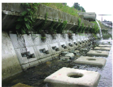
使用生态护坡产品后的河道
