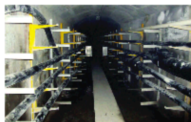
电力隧道电缆敷设后完工图
