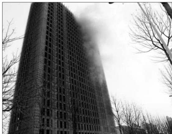
浓烟从在建大楼楼顶冒出。 本报记者 王亚男 摄
