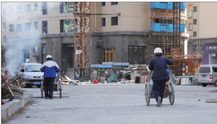
建筑工地施工安全将成今年的管理检查重点。 本报记者 王鸿哲 摄
