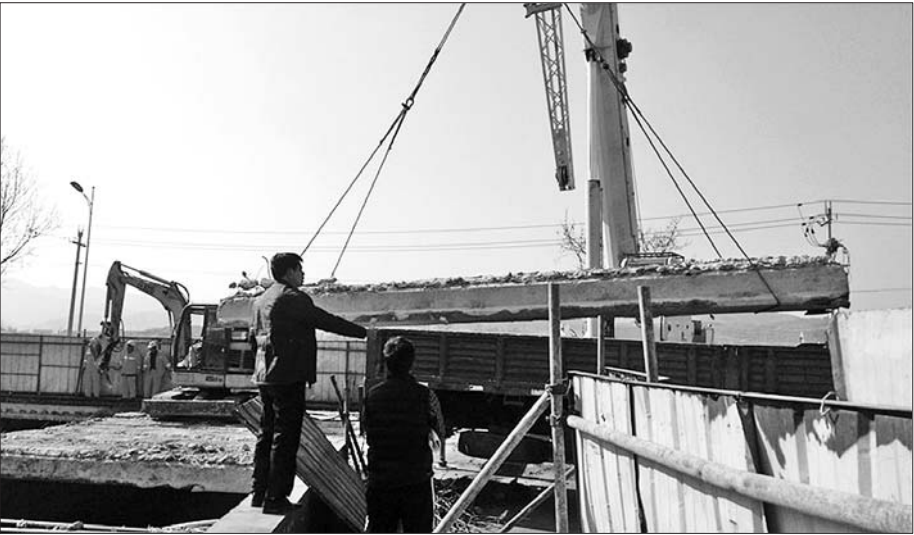
13日上午,成龙线曲家河桥施工现场,工程施工人员正在用吊车更换桥板。 记者 冯琳 摄
