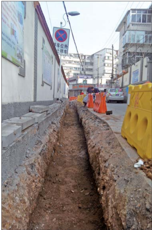
历下区实施双气入户工程。
