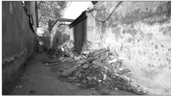
巷子内堆放的建筑垃圾。 本报记者 杨双媛 摄
