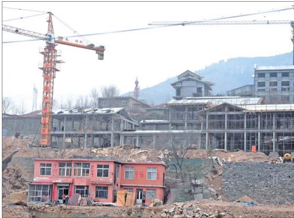
正在建设中的门牙景区还远未达到五一接待游客的条件。 本报记者 周青先 摄
