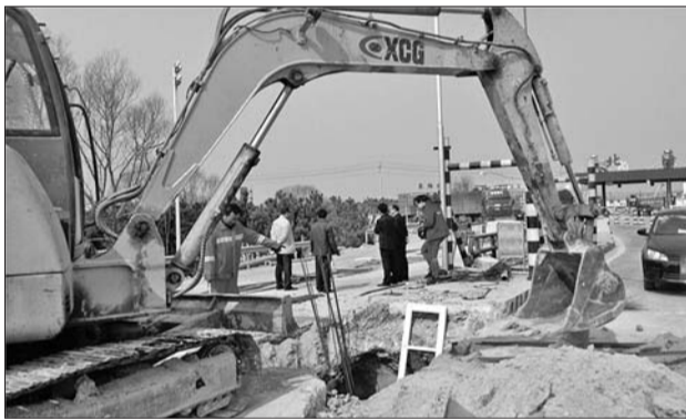
荣乌高速北海收费站处,拓增车道及建遮雨棚的工程正在同时进行。 记者 冯琳 摄
