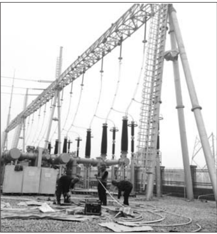
胡集220千伏变电站已进行电气安装。 本报记者 康宇 摄
