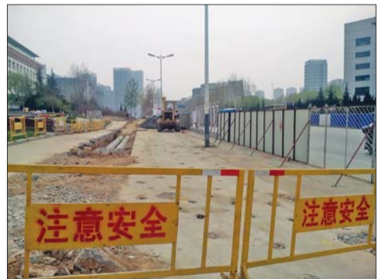
道路改造施工现场。
