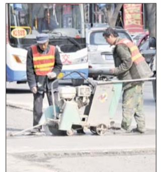
4月7日,工作人员在利民路上修补路上的坑。据了解,针对城区主干道损坏的路面,最近将统一修补。
