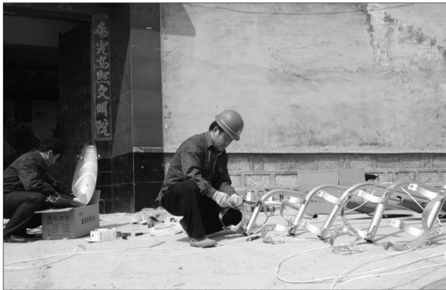
在李庄镇桑树王村,电工正在为村里安装路灯。本报记者 王璐琪 摄
