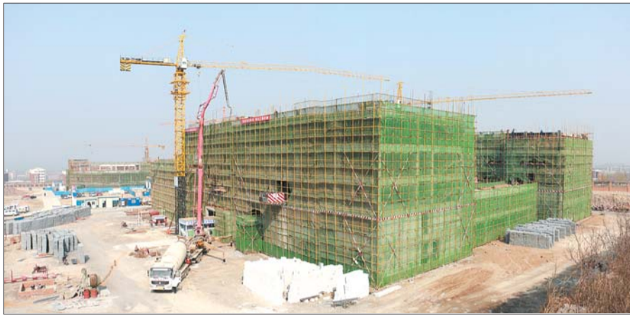
一期工程封顶现场
