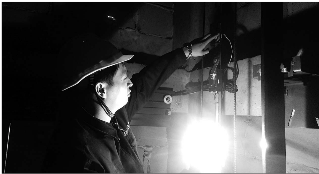
电梯检验人员在井道内检查。本报记者 高雯 摄
