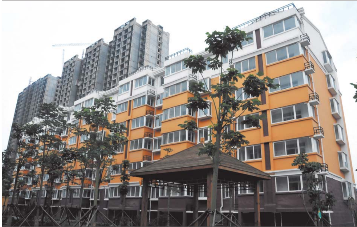
城区一在建的经适房小区(资料图)。 本报记者 张晓科 摄
