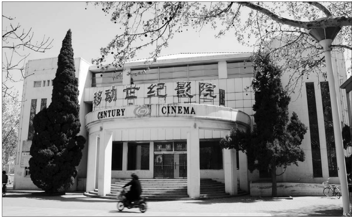
4月16日,位于明月湖景区内的世纪影院内部已经拆空,准备安装钢构支架。 本报记者 马志勇 摄
