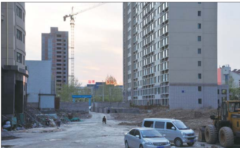
施工现场应实行封闭管理,抑制扬尘。 本报记者 王鸿哲 摄
