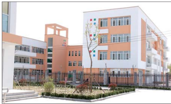
「第一书记」援建的小学校教学楼一角。
