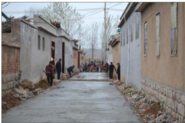
道路施工现场。本报通讯员 摄
