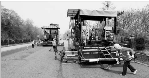
28日,省道黄水线大修工程施工现场。通讯员供图
