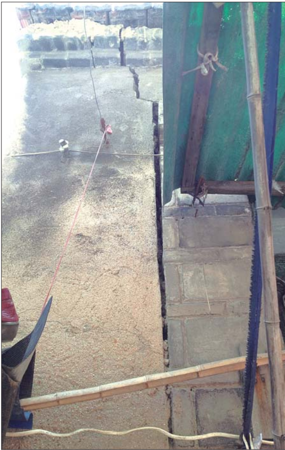
状元府最南侧房屋外墙裂缝超过2米长,可伸进手指。
