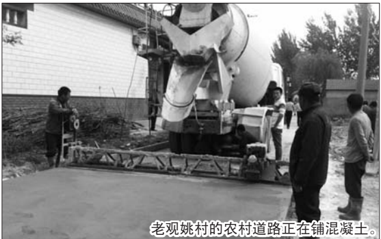
老观姚村的农村道路正在铺混凝土。
