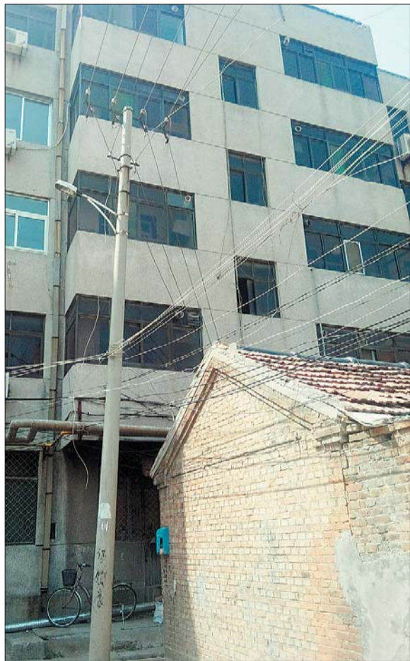
县法院家属楼,住户从电线杆上接出的电线。
