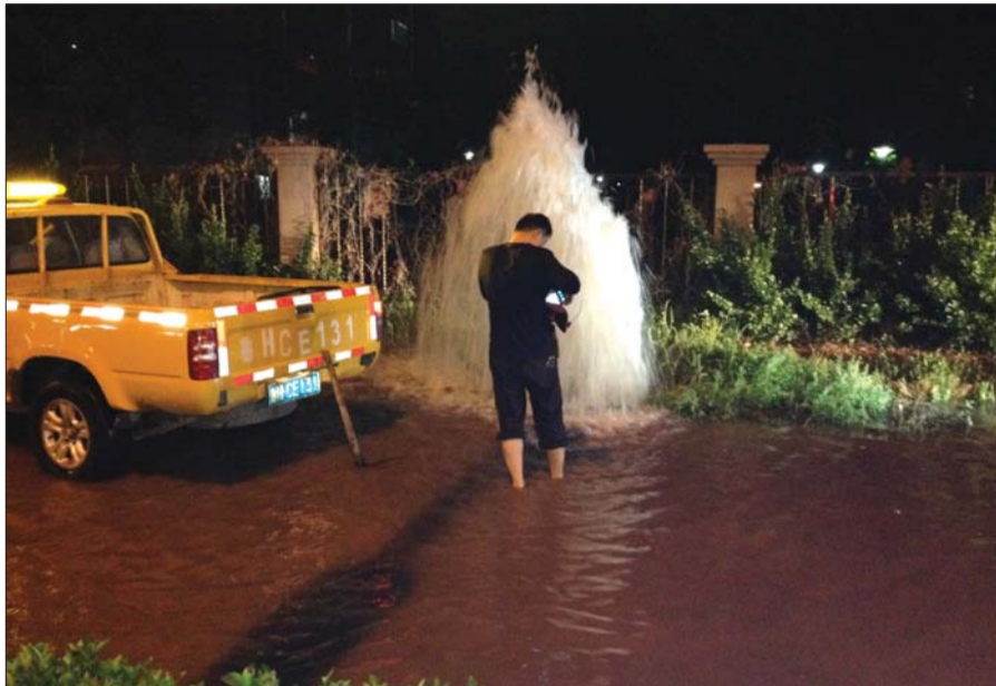
被撞断的消防栓处,水柱喷起2米多高。本报记者 孟杰 摄
