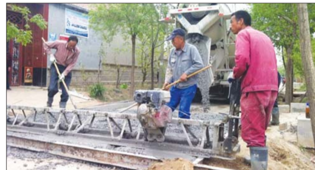
沾化区东三里村的施工队正在往道路上铺混凝土。
