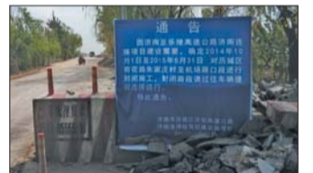
封闭施工的荷花路东段。 本报记者 蒋龙龙 摄
