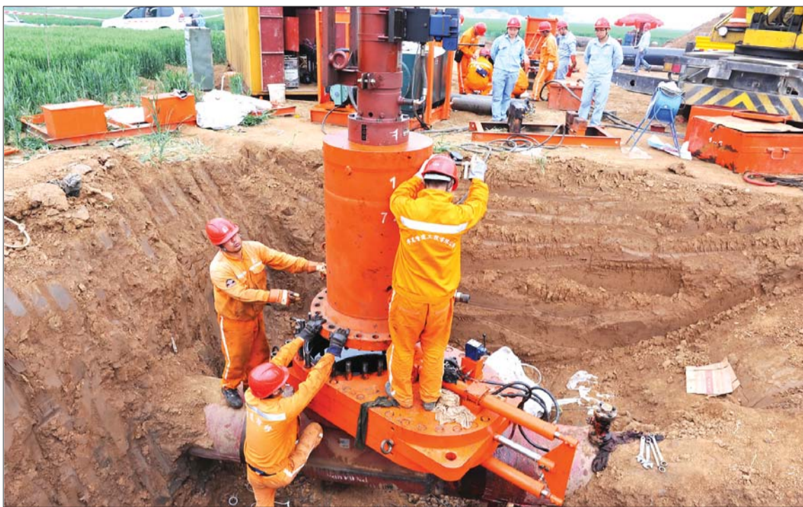
输油管线施工现场。
