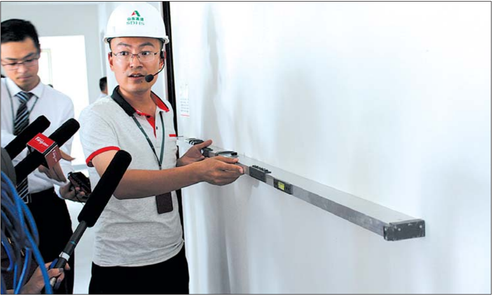
工程师在现场测量墙面水平极差。
