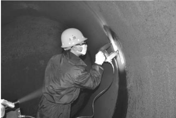
用无损检测技术进行容器检验
