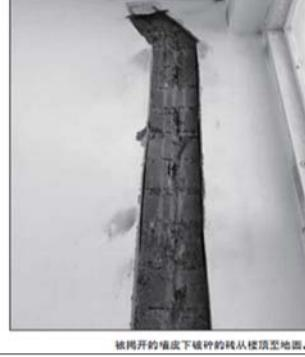
现场 &gt;&gt; 基本上每户都有裂缝,且墙壁两面相吻合
