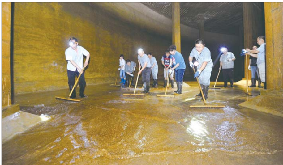
济南水务集团工作人员正在对马鞍山加压站的地下清水池进行清刷。 本报记者 蒋龙龙 摄
