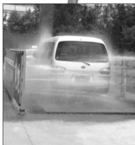
出工地的车辆都要经过这样的清洗。
