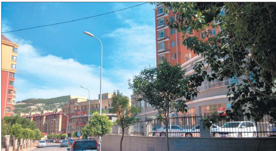
位于旅游路南侧的多个小区存在供水难题。 本报记者 蒋龙龙 摄
