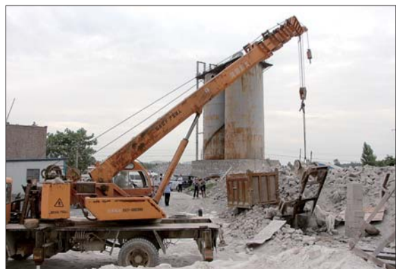
巨野县对核桃园镇境内的污染源石灰窑进行了全部的封停,截断高压电、封停石灰窑,挪走其设备等等。 满常学 摄
